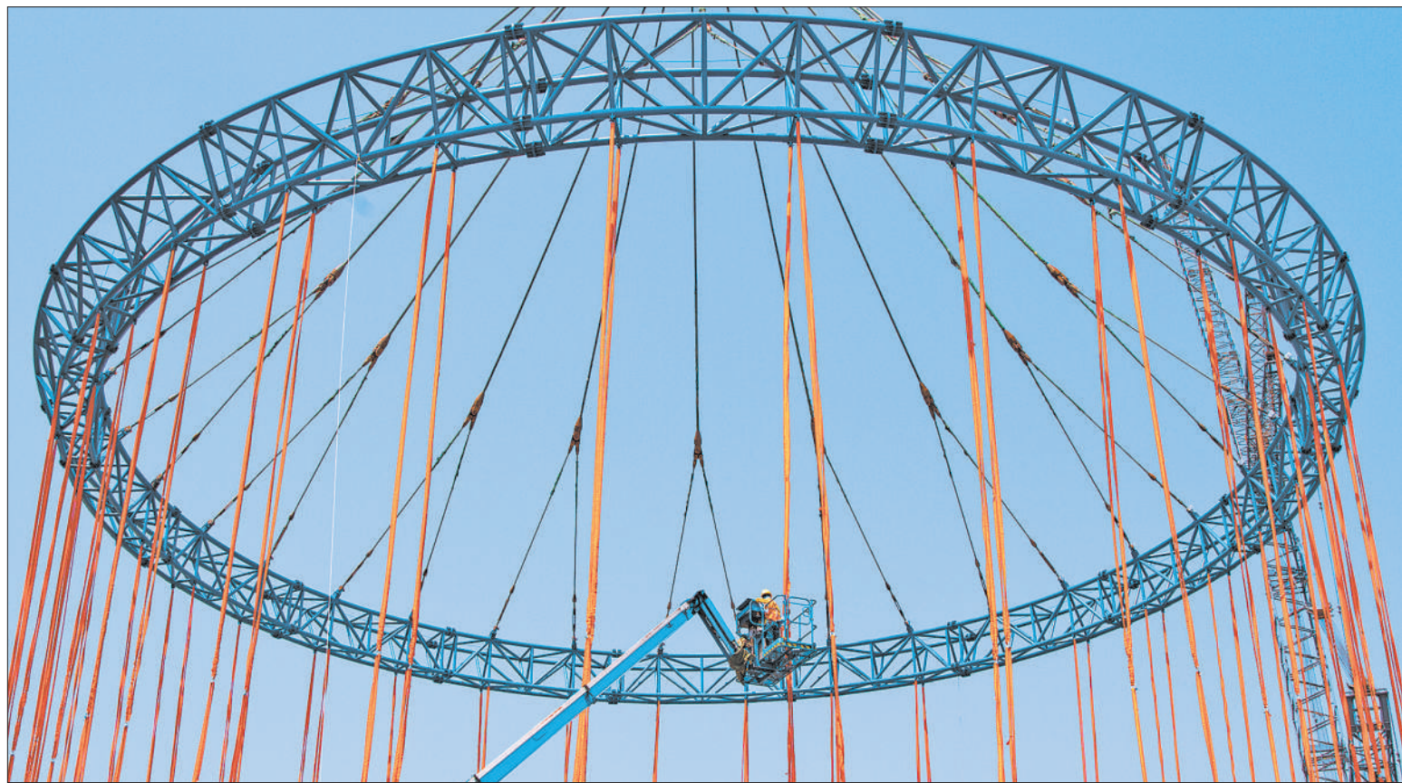
在“国和一号”示范工程某大型模块吊装现场，工人乘坐升降梯检查吊具。
