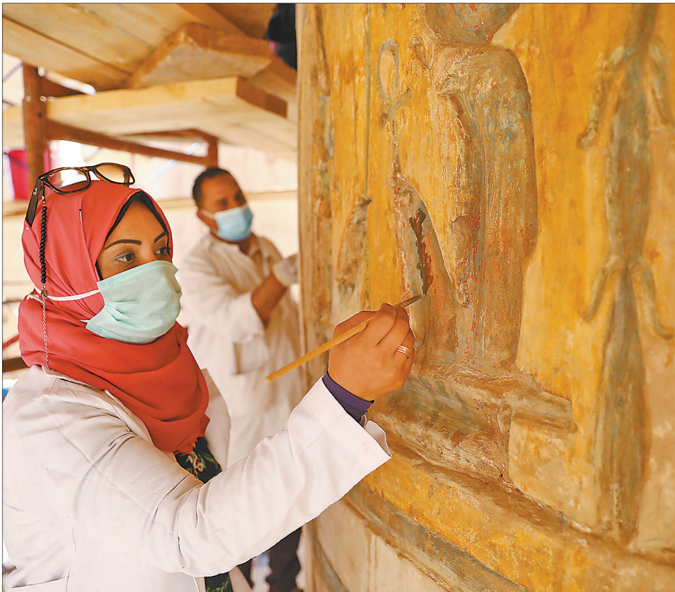
日前,埃及对位于南部城市卢克索的多处文物古迹开展修复保护工作。图为8月25日,工作人员在卡纳克神庙建筑群进行修复工作。
