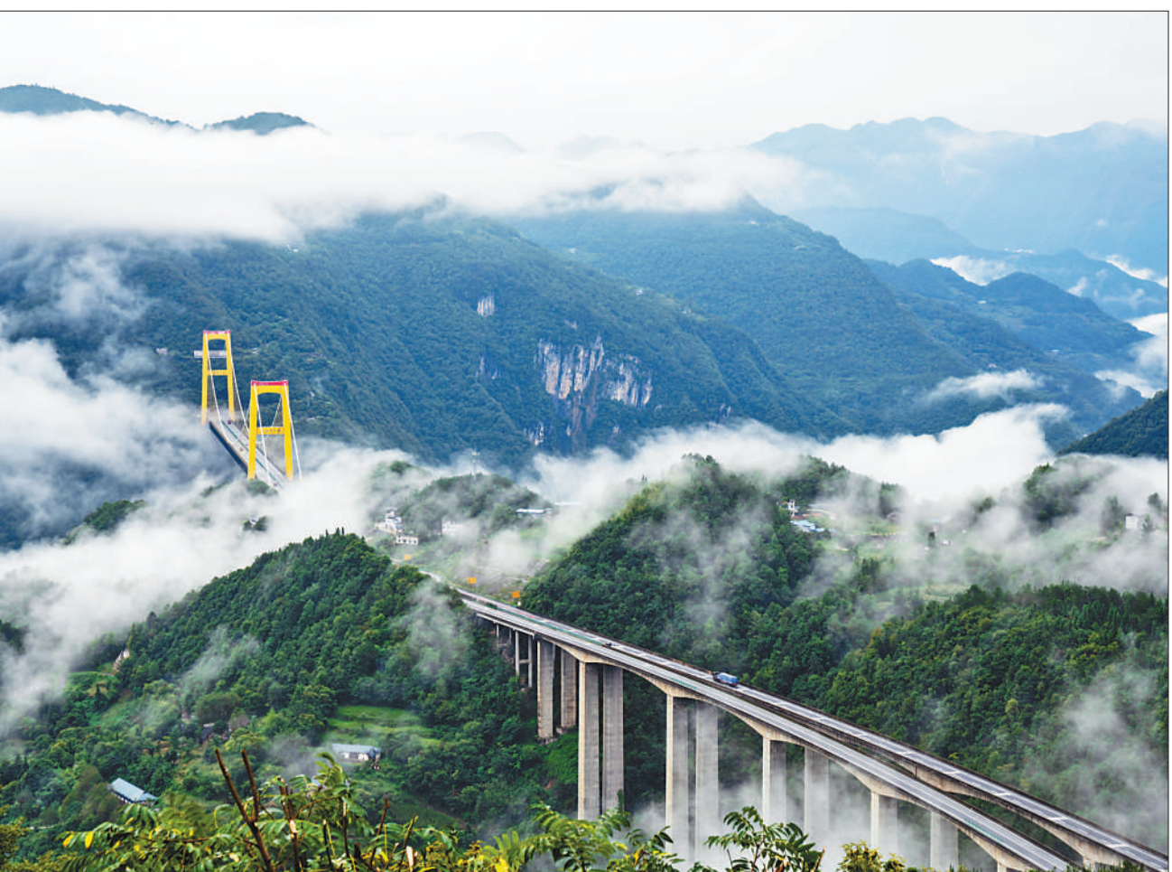
四渡河特大悬索桥地处湖北宜昌市与恩施土家族苗族自治州交界处,全长1365米。截至目前,湖北恩施境内高速公路里程达588公里,沿线经济社会发展水平得到提高。图为8月24日,四渡河特大悬索桥景色。 文 林摄(人民视觉)
