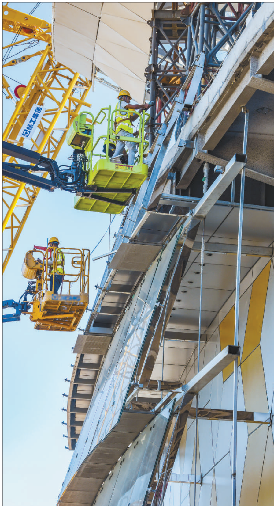
8月20日,海口市国际免税城地块五项目现场机械轰鸣,工程车来回穿梭,塔吊来回旋转,项目建设热火朝天。图为工人正在安装外立面幕墙。
