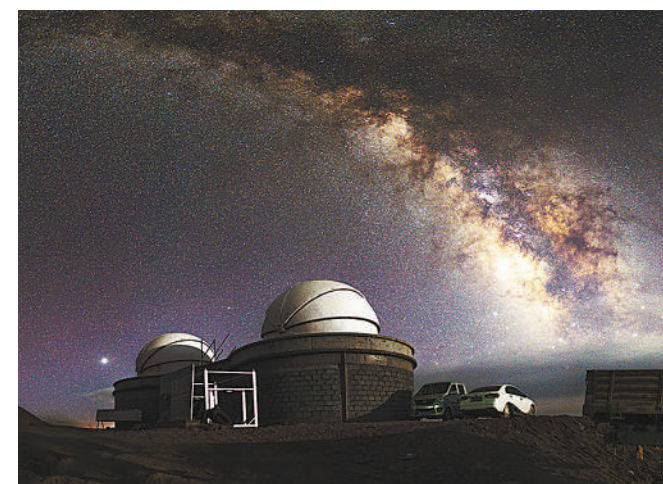
图为施工中的冷湖赛什腾山台址。
