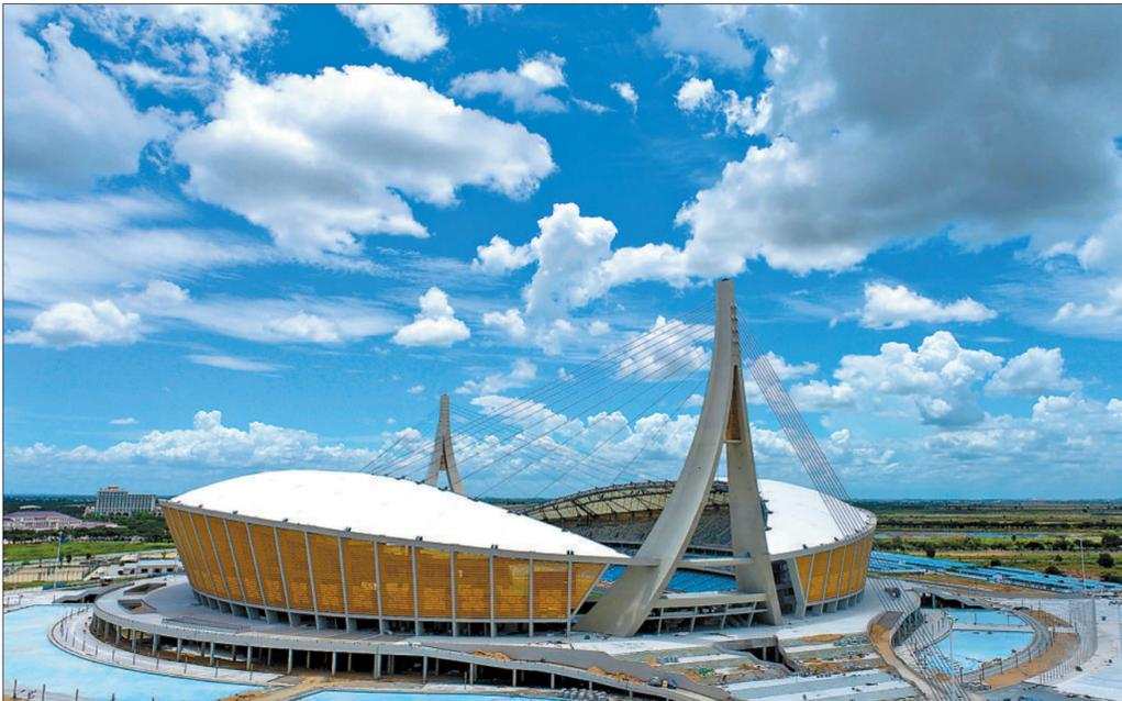
由中国政府援建、中国建筑股份有限公司承建的柬埔寨国家体育场项目日前通过竣工验收。该体育场坐落在柬埔寨首都金边北部市郊,两端99米高的人字形吊塔融合了柬埔寨的“合十礼”、古代建筑屋脊等传统元素,通过钢索拉起看台上方的罩棚膜,如一艘巨轮扬起风帆。
