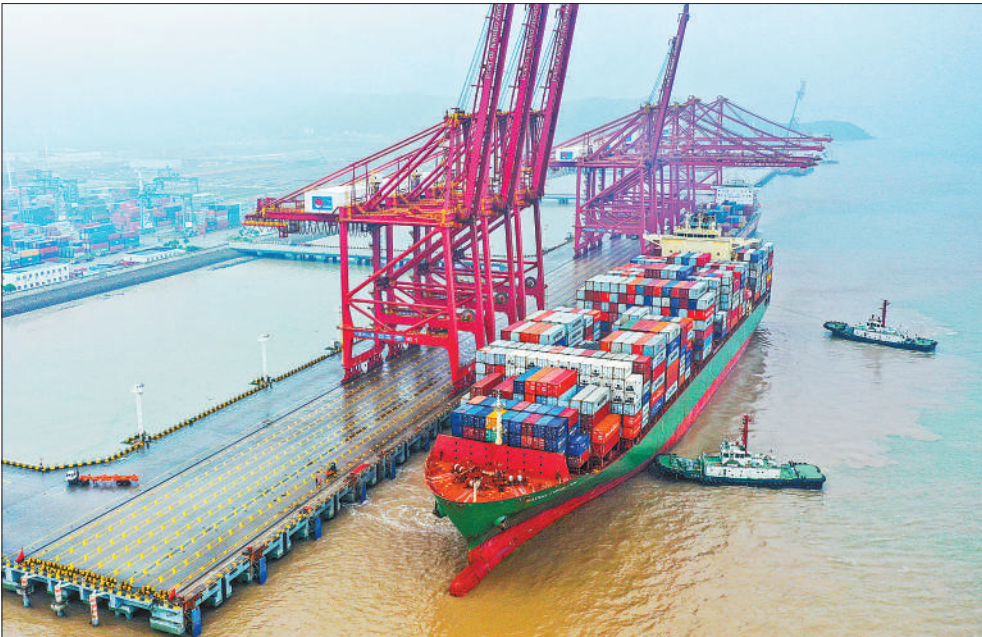
8月16日,浙江宁波舟山港金塘港区大浦口集装箱码头,一艘集装箱轮正在靠泊。截至目前,该集装箱码头已拥有“一带一路”国际集装箱航线18条,今年累计完成集装箱吞吐量94.04万标准箱,同比增长11.59%。姚峰摄(影像中国)
