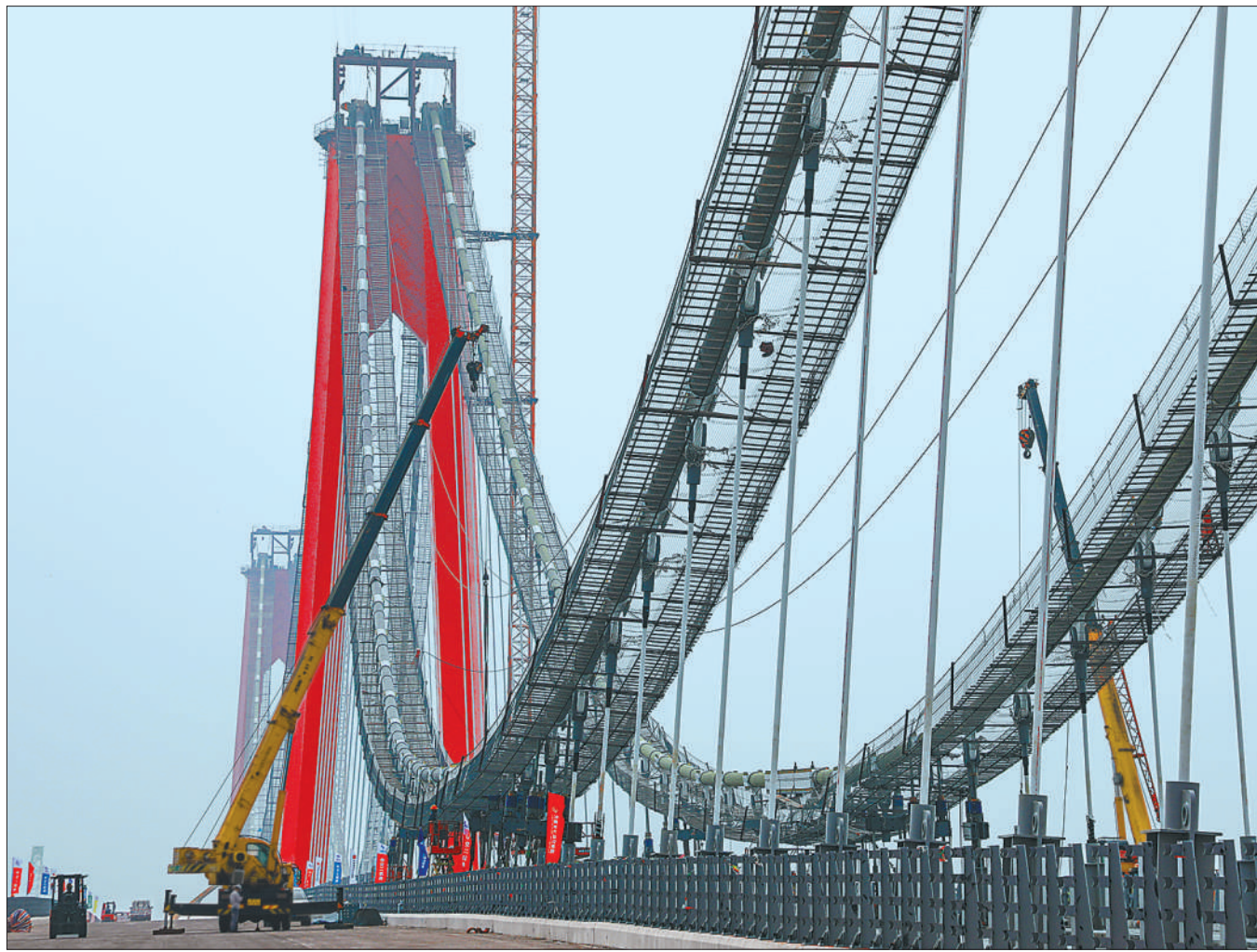
8月13日，济南凤凰黄河大桥正在加紧施工。据了解，济南凤凰黄河大桥按照双向八车道一级公路标准建设，采用“公轨同层，轨道居中”的设计方案，计划今年10月建成通车。徐舟摄（影像中国）
