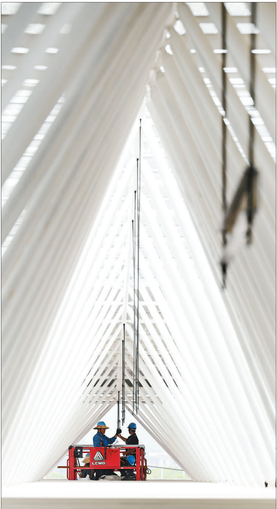
8月11日，工人在广西柳州一新能源汽车项目焊装车间的屋顶作业区安装管道设施。近年来，广西柳州市大力发展新能源汽车产业，不断提升新能源汽车的研发和生产能力，新能源汽车销量不断攀升。
