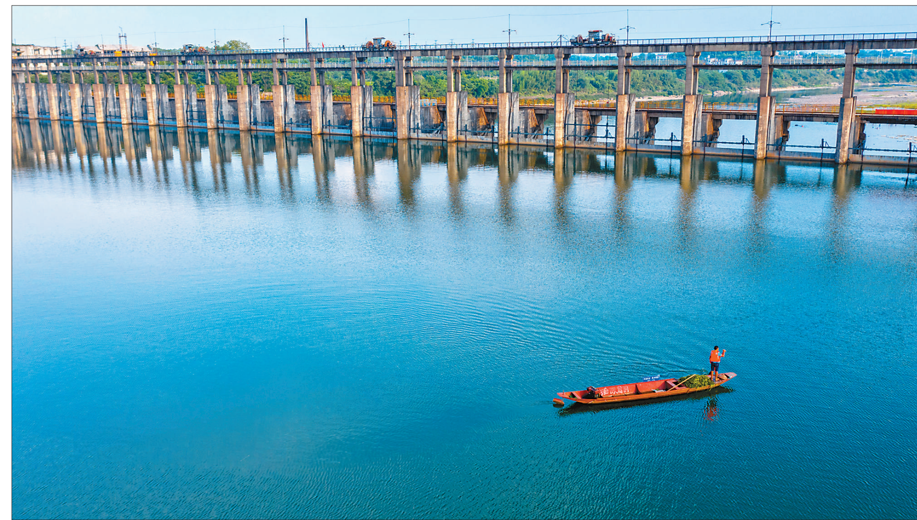
近年来,湖南省东安县依托河长制加强河道治理,将水面垃圾清理纳入人居环境整治和村庄清洁行动中,确保青山常在、绿水长流。图为8月8日,河道保洁员在湘江东安县石期市镇蒋家村段开展清理工作。
