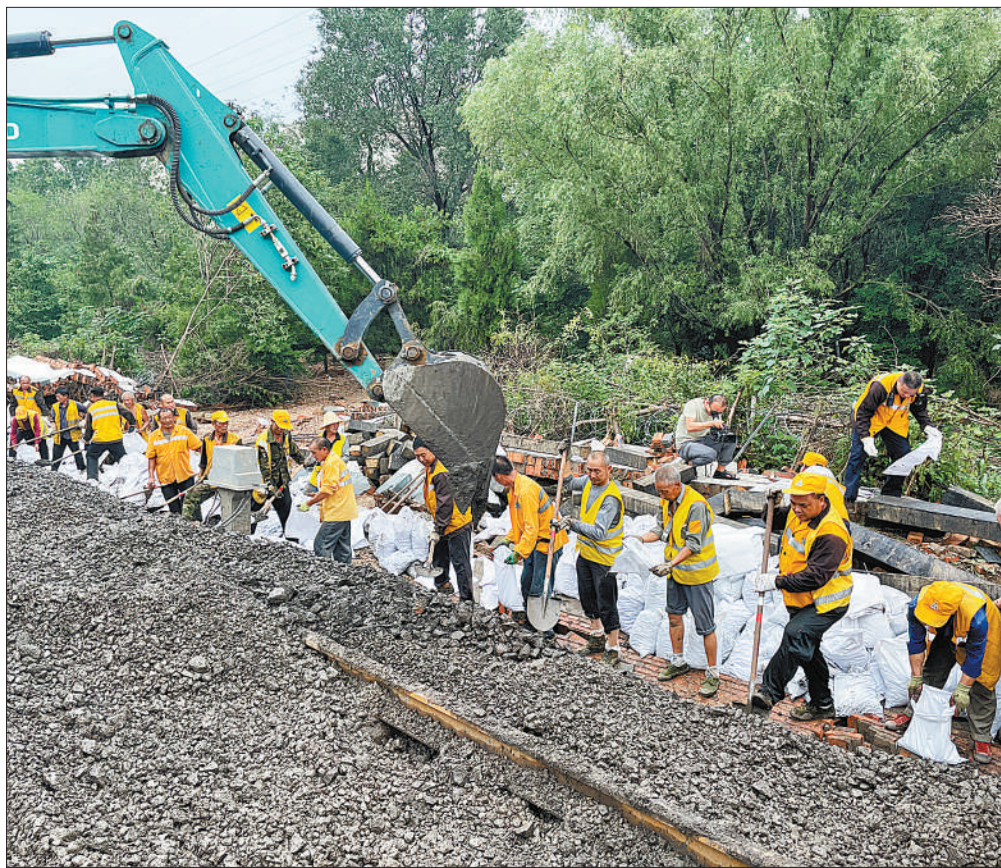
7月20日,暴雨导致京广线南阳寨与海棠寺线路区间出现路基下沉险情。中国铁路郑州局集团有限公司组织人员连续奋战40多个小时之后,受损区域已经抢修完成。赵晶摄(人民视觉)
