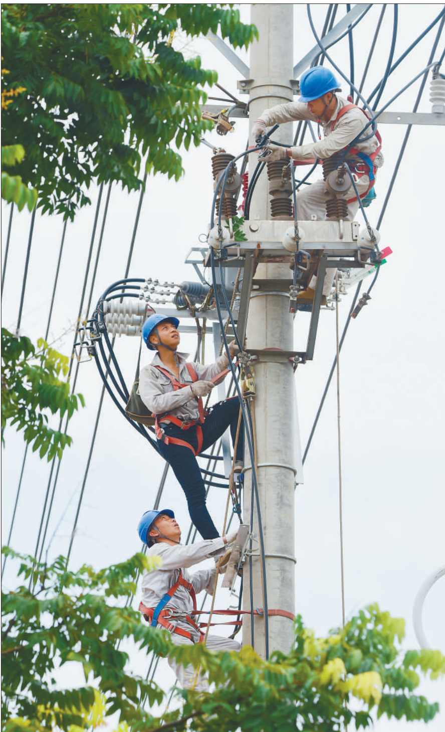
连日来，湖南郴州国网嘉禾县供电公司对照区内电力设备进行检修、维护、改造，实施有序供电，合理分配电力负荷，确保夏季高峰用电安全。图为7月20日，嘉禾县经济开发区，供电公司员工在进行线路改造维护。黄涛涛摄（影像中国）
