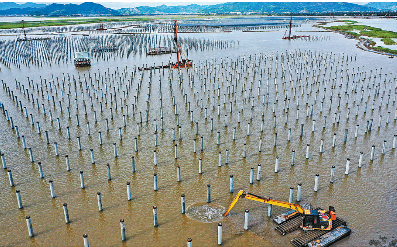
7月19日，浙江玉环市苍山塘1800亩海涂100兆瓦“渔光互补”光伏发电项目工程正在建设中。玉环市在开展光伏发电项目建设的同时，有效利用资源，形成“棚上发电、棚下养鱼”的综合利用新模式，可实现年均发电量约1.4亿千瓦时，每年节约标准煤约4.4万吨，减少二氧化碳排放量11万吨以上。
