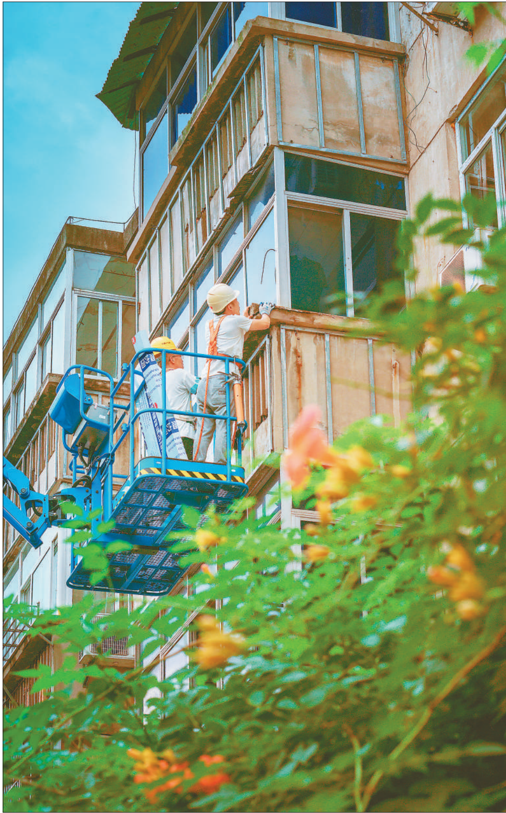
今年，安徽马鞍山计划对76个小区进行改造，涉及住户54319户，改善老旧小区的环境面貌，提升市民的生活幸福感。图为7月18日，马鞍山花山区老旧小区改造现场，工人正在施工。张明伟摄（影像中国）
