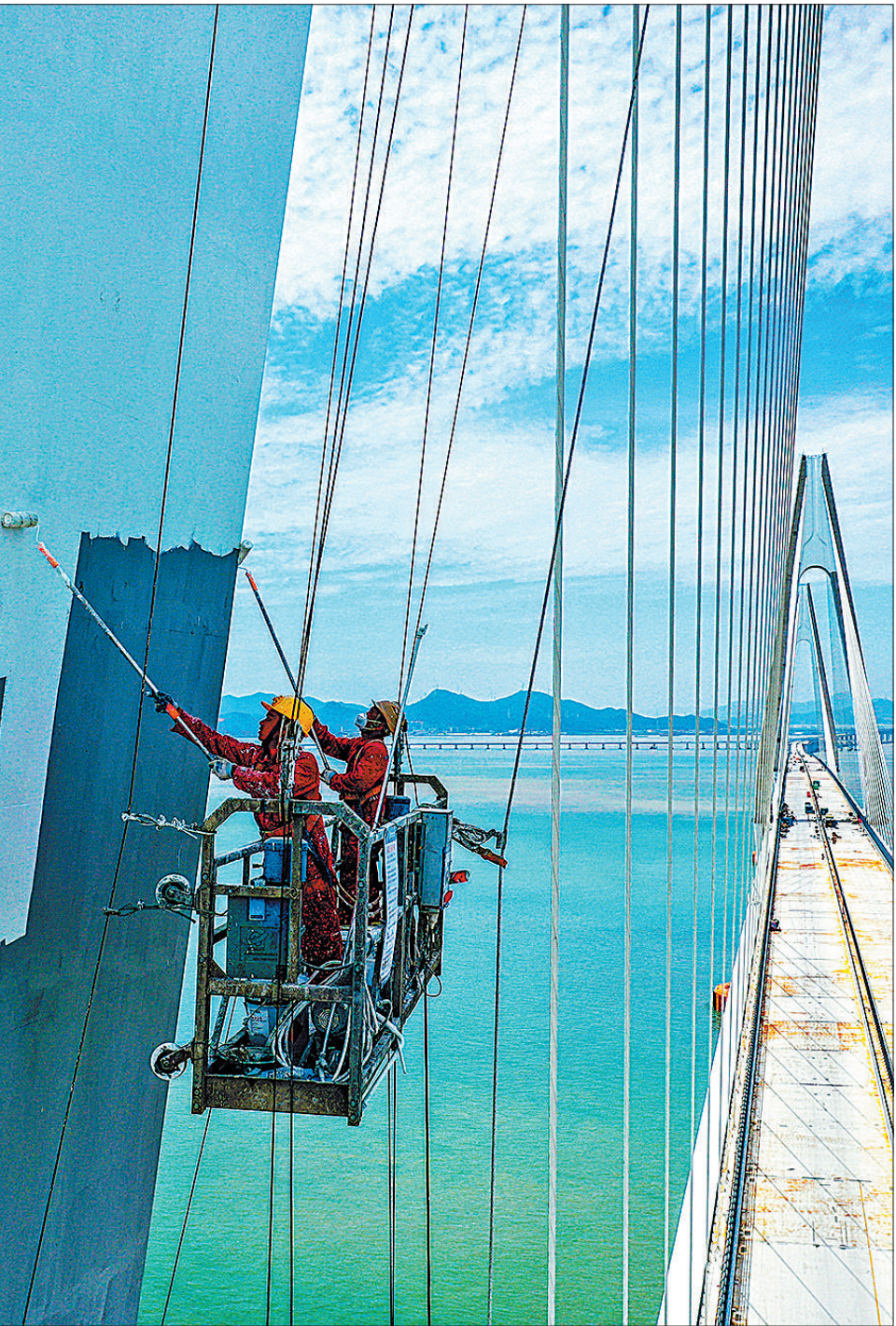
7月12日，工人正在150米的高空中为宁波舟山港主通道项目舟岱大桥主塔进行涂装施工。舟岱大桥主塔涂装施工将依次对主通航孔桥主塔进行底层、中间层、面层的涂装。姚峰摄(影像中国)
