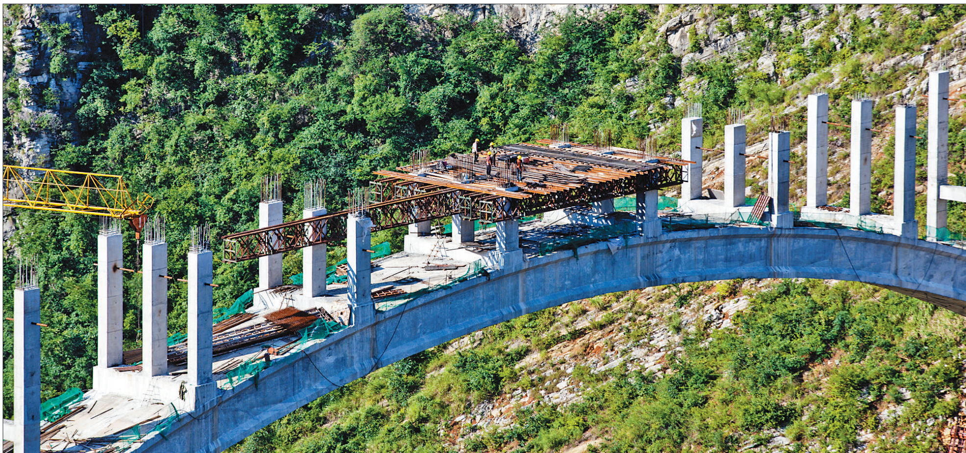
贵州夹岩水利枢纽工程是以城乡供水和灌溉为主，兼发电的综合大型水利枢纽工程。7月11日，工人在该工程的白甫河倒虹管跨河拱桥上进行桥面板施工。
