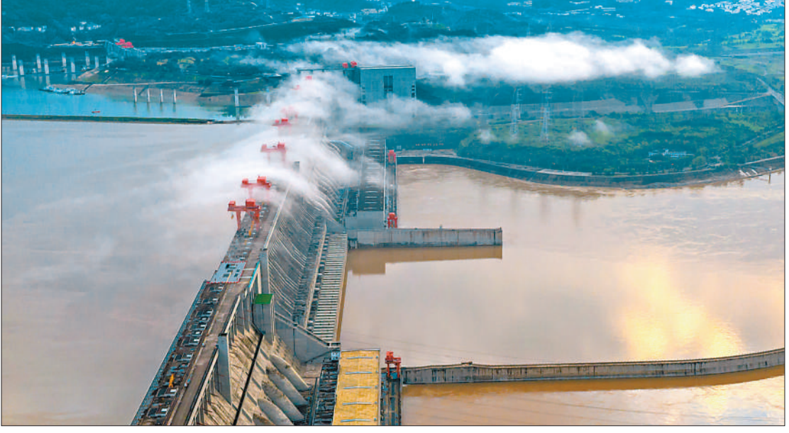
7月7日20时，三峡集团所属长江干流6座梯级水电站全部96台机组首次全开运行，高峰总出力达5201万千瓦，全力协助电网错峰度夏。 图为7月8日拍摄的长江三峡枢纽工程。 郑家裕摄（人民视觉）
