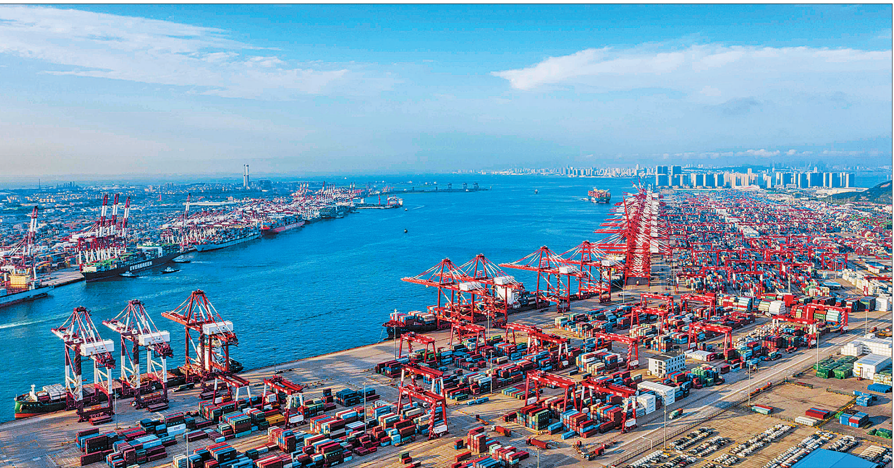
7月6日，山东港口青岛港前湾港区外贸集装箱码头上，一艘艘集装箱船在码头的泊位上有序装卸货物，一派繁忙景象。
