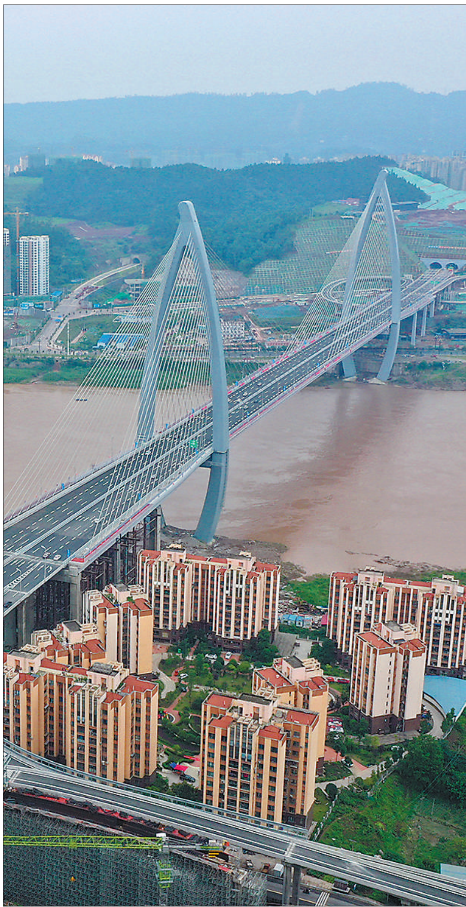
7月1日,横跨四川宜宾三江新区和叙州区的盐坪坝长江大桥通车试运行。
