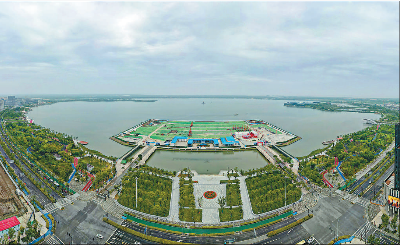
6月20日，2021年上海自贸区临港新片区第二季度建设工程项目集中开工。本次集中开工项目涵盖金融、生态、科技以及居民住宅等多个领域，共计12个项目。图为中银金融中心项目现场。
