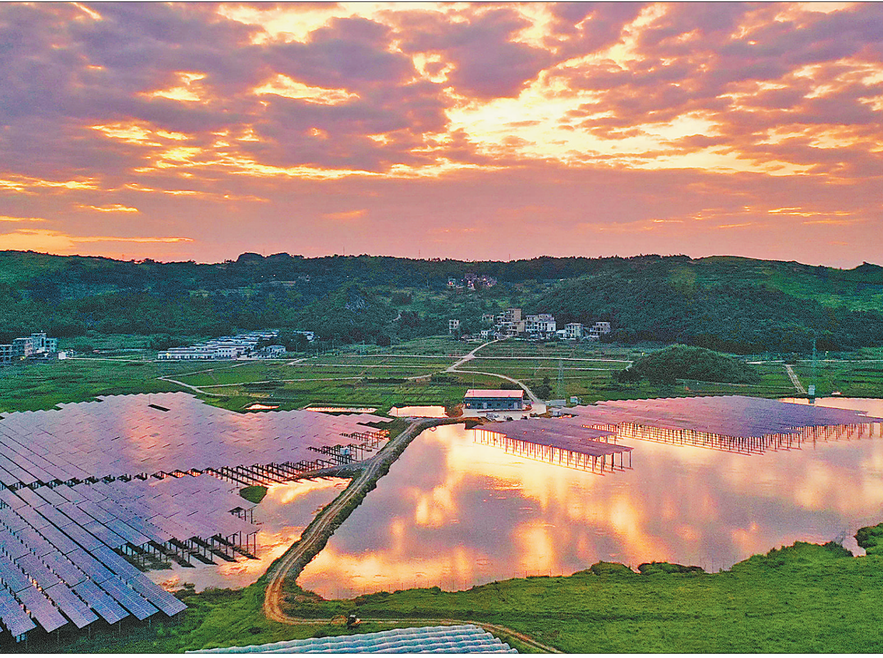
为巩固脱贫成果、推动乡村振兴,湖南省永州市宁远县太平镇五里坪村利用水库资源,建设水上光伏电站。据了解,该项目实现储水灌溉、光伏发电和渔业养殖一体化,既节约土地资源,又发展了绿色清洁能源。
