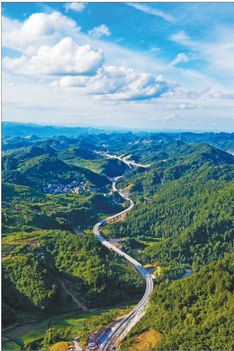
近日,湖南省凤凰县磁浮文旅项目加紧建设。该项目是连接张吉怀高铁凤凰站与凤凰古城旅游景区的新型轨道交通线路,建设完成后将极大提升当地旅游服务质量,带动地方经济转型。
