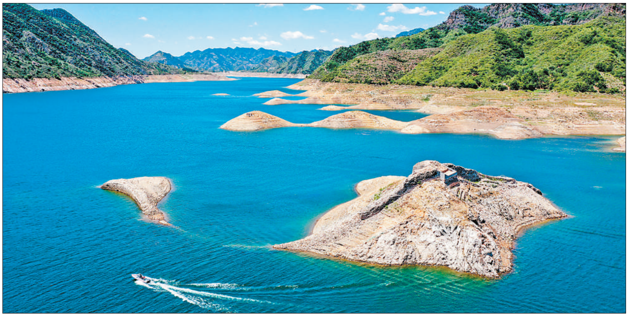
近日，河北唐山，喜峰口西潘家口段长城保护维修工程正在加紧施工。20世纪70年代，潘家口水库修建后，潘家口关城和部分长城淹没到水下。此次修缮对象为该段长城枯水季节露在水面之上的部分。
