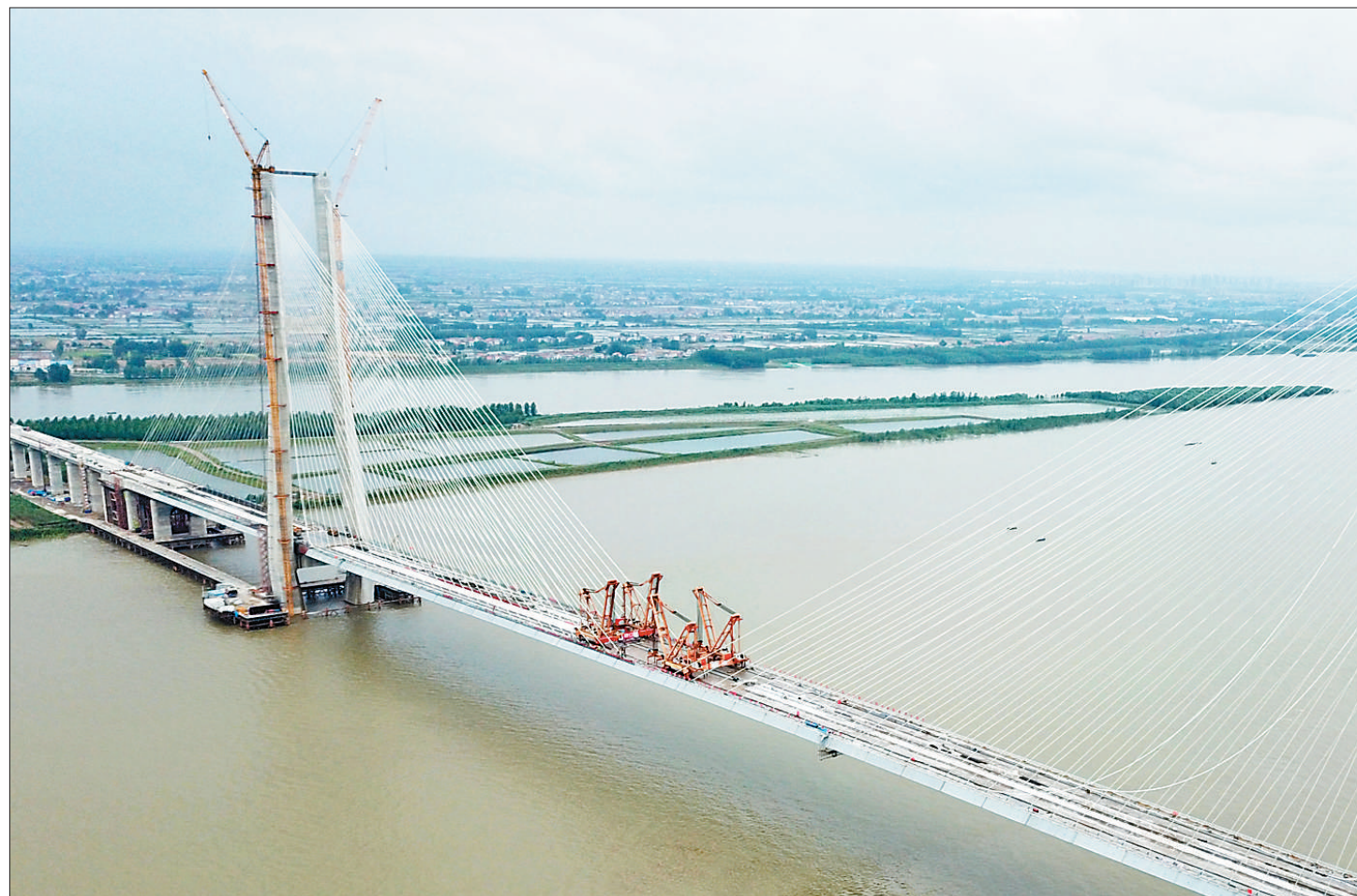
6月3日,安(庆)九(江)铁路鳊鱼洲长江大桥合龙。鳊鱼洲长江大桥北側位于湖北,南側位于江西,按照两线高铁及两线预留客货共线标准建设,高铁线时速350公里,预留客货线时速200公里。
