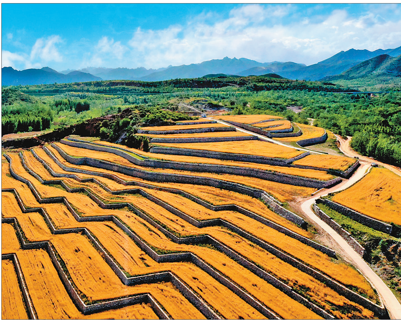
北京市房山区积极践行“绿水青山就是金山银山”理念，投入财政资金在大石窝镇实施土地整治项目，将原来的工矿废弃地改造造成配套齐全、设施完善的农田生态系统，不仅增加了有效耕地面积，也改善了区域生态环境。图为近日，项目区今年首次播种的小麦长势喜人，正等待收获。
