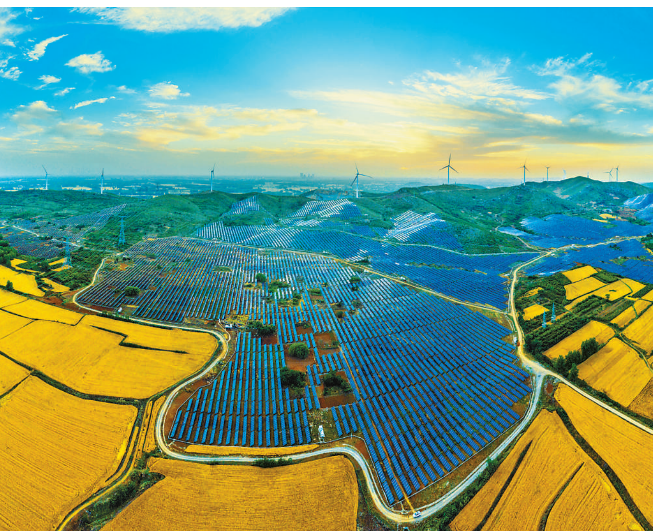
近年来,安徽省宿州市将绿色发展理念贯穿能源产业链条,通过开展风、光、生物质等新能源的综合利用,优化能源结构,有效减少煤炭等传统化石能源带来的污染。同时,宿州将新能源产业向山区拓展,利用荒山荒坡建设风电及光伏项目,不仅推动当地的社会经济发展,还带动群众增收致富。图为宿州市风电及光伏项目。苗地摄(影像中国)
