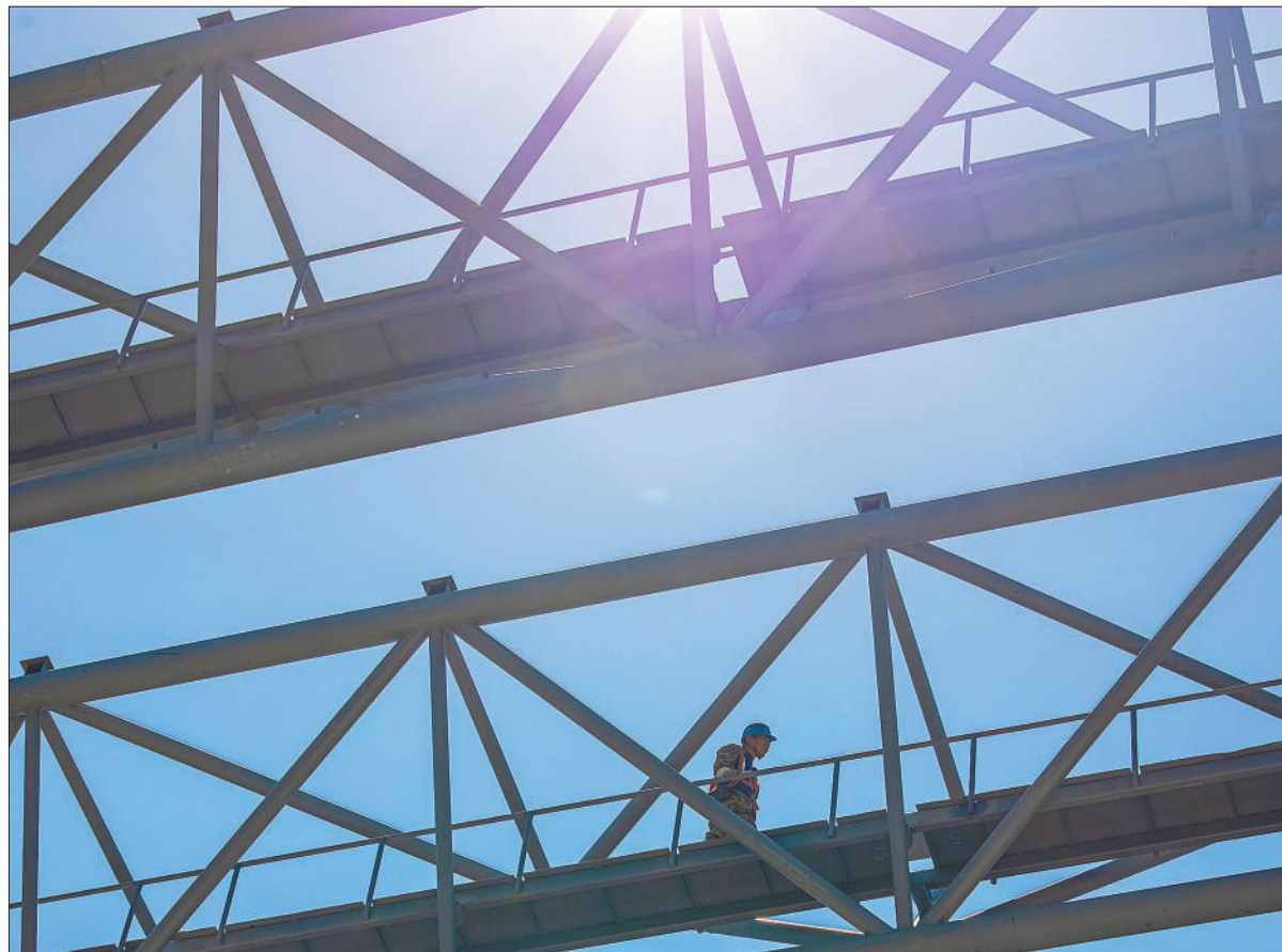
5月28日，我国首座采用高速、普速客运车场重叠布置的大型车站——北京丰台站实现主体结构全面封顶。该站作为助力京津冀协同发展的重要铁路交通枢纽，建成后将成为京广高速铁路、京港台高速铁路等多条线路始发终到作业。图为5月28日，工人在站房顶部作业。本报记者 张武军摄
