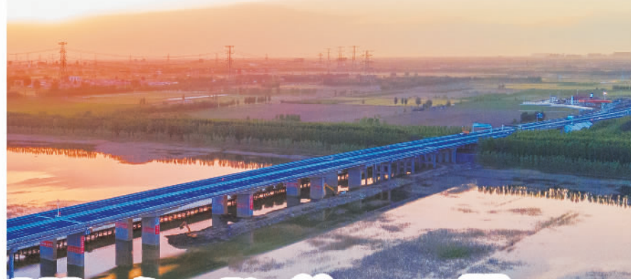
京德高速公路文安洼1号特大桥跨赵王新河连续梁
