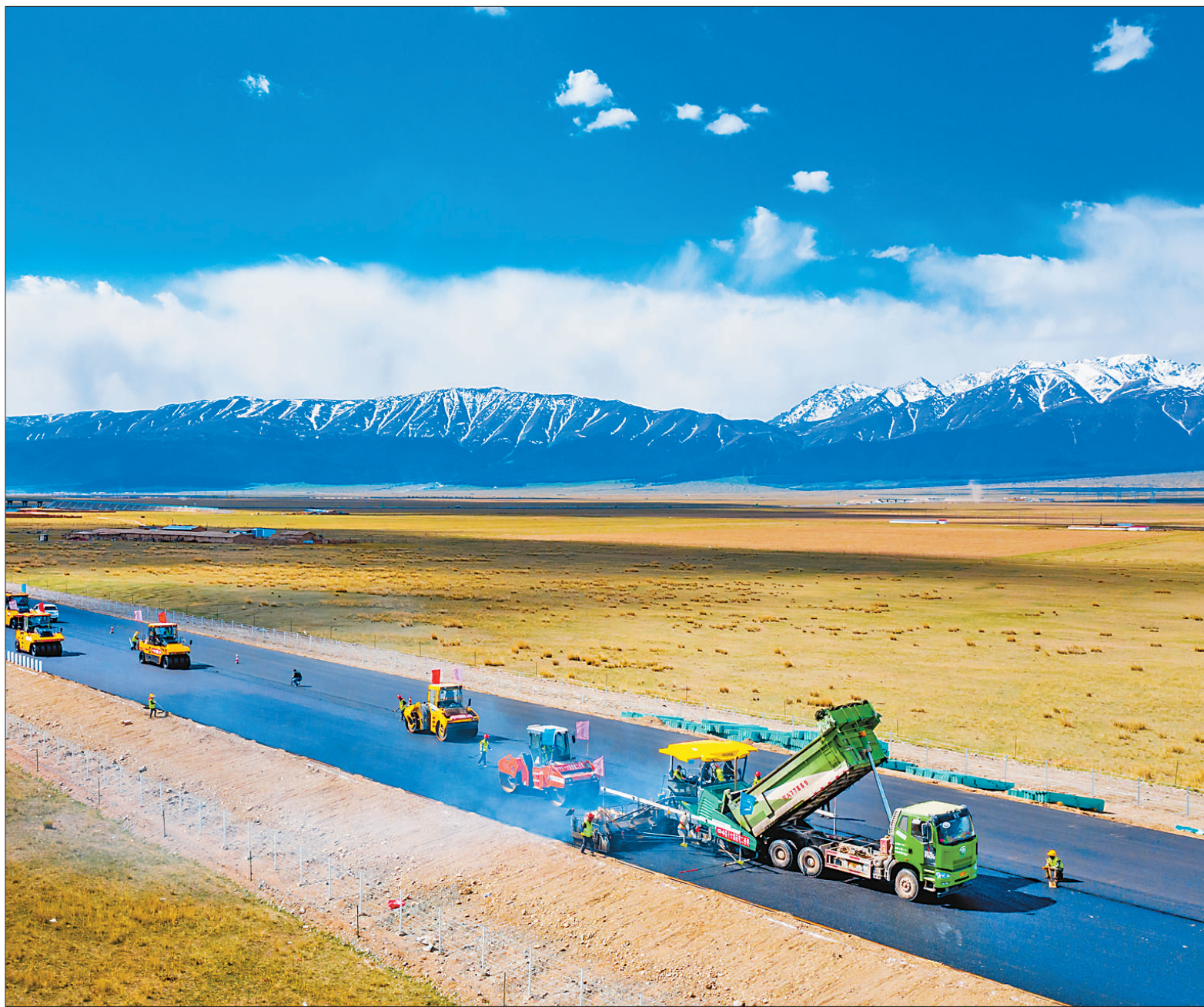
5月20日，京新高速公路与G575线新疆哈密至巴里坤段项目的交界处在铺设沥青。京新高速起于北京，终点至新疆乌鲁木齐，是“一带一路”通道的重要组成部分。 普拉提·尼亚孜摄(影像中国)
