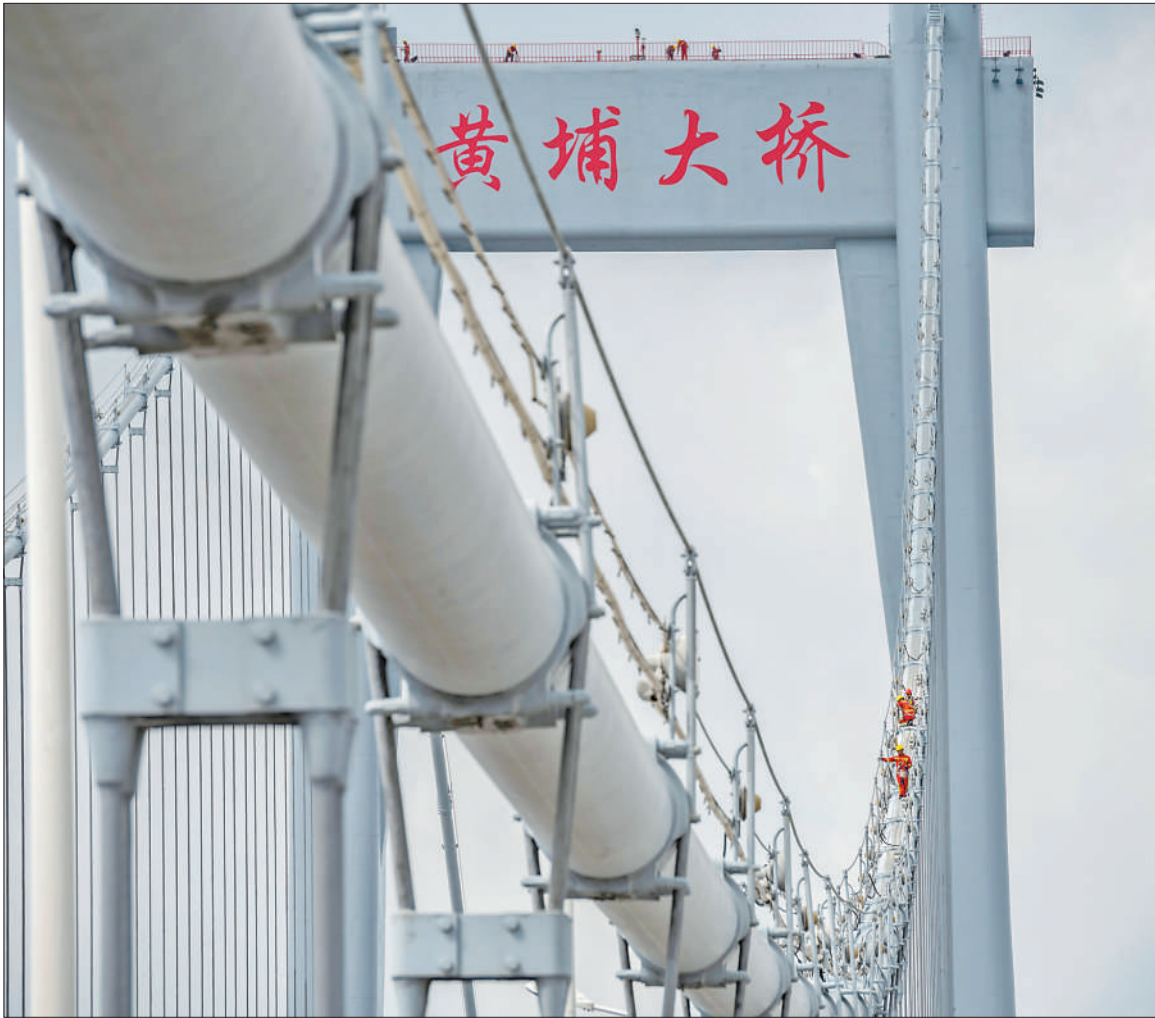
日前,中交养护集团技术人员对广州珠江黄埔大桥开展防火防腐专项养护工作。养护人员冒着夏日高温,在大桥上对主缆和拉索采用玄武岩纤维材料、耐火阻燃密封胶等新材料进行密封、耐火隔热和抗力损伤防护施工,提高大桥的安全系数。
