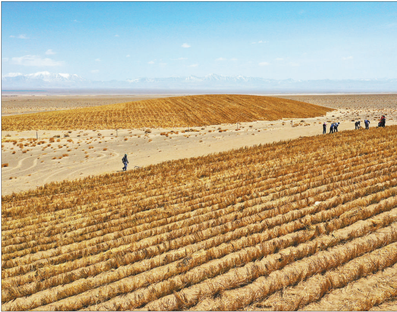
5月12日,祁连山腹地的甘肃省阿克塞哈萨克族自治县哈尔腾草原,工人们在沙丘上用稻草压沙,进行草原沙化治理。
