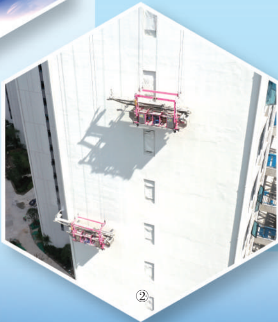
图②:碧桂园旗下子公司博智林研发的外墙喷涂机器人正在作业。
