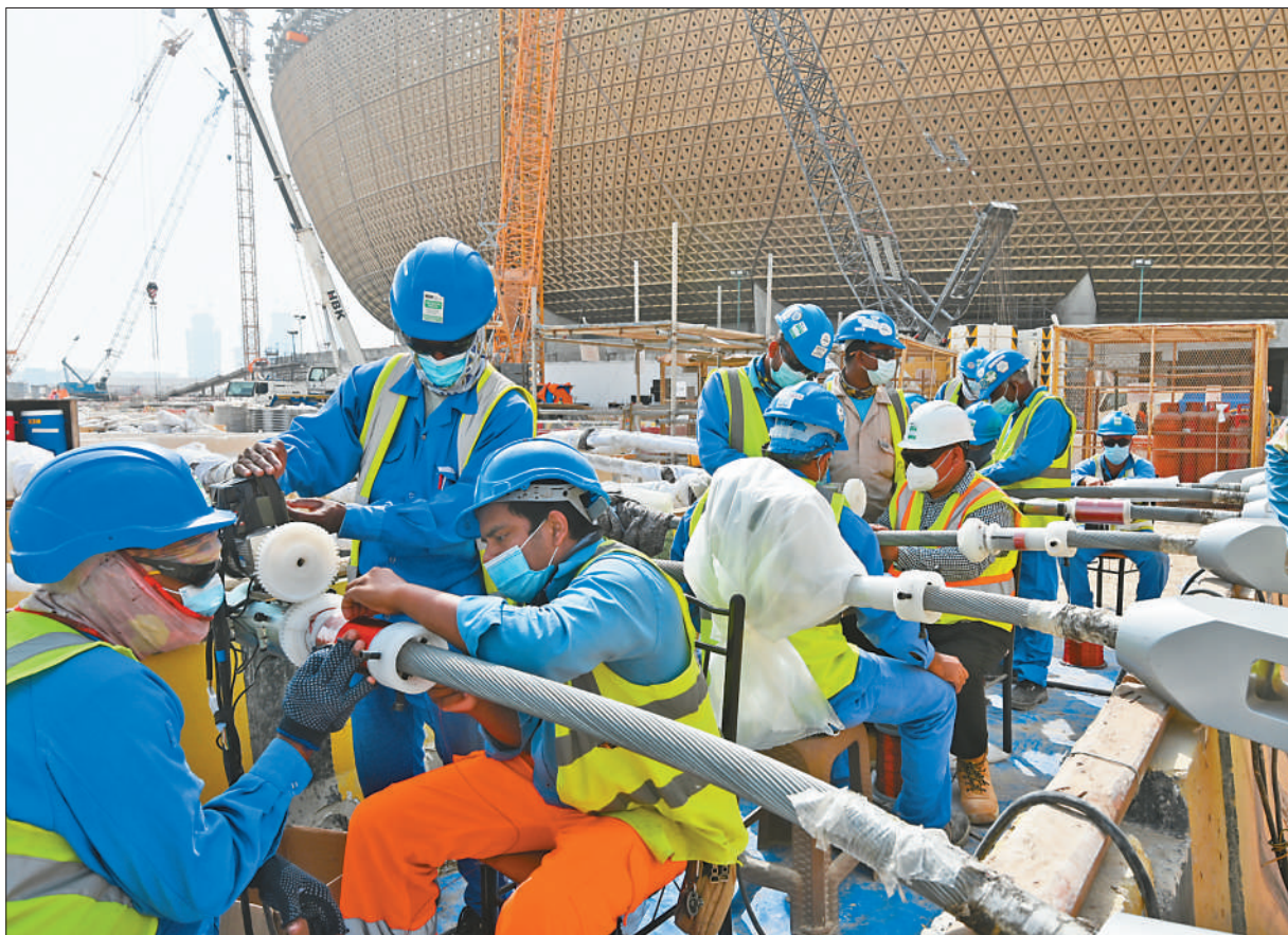
中外建设者在为卢赛尔体育场安装索力监测设备。
