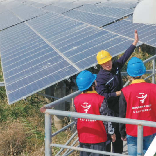
国网温州供电公司员工检查光伏设施及并网设备
