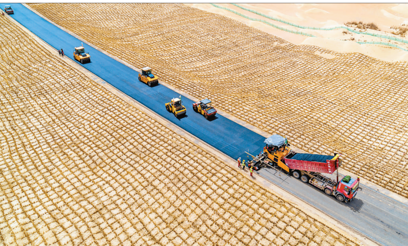
新疆尉犁至且末沙漠公路自2017年10月开工，路线全长约334公里，沙漠腹地里程长304公里。项目建成通车后，将带动沿线各类资源开发，对于完善国家公路网、推动当地经济社会发展具有重要作用。图为4月27日，尉且沙漠公路铺油作业现场，沥青摊铺机正在加紧施工。
