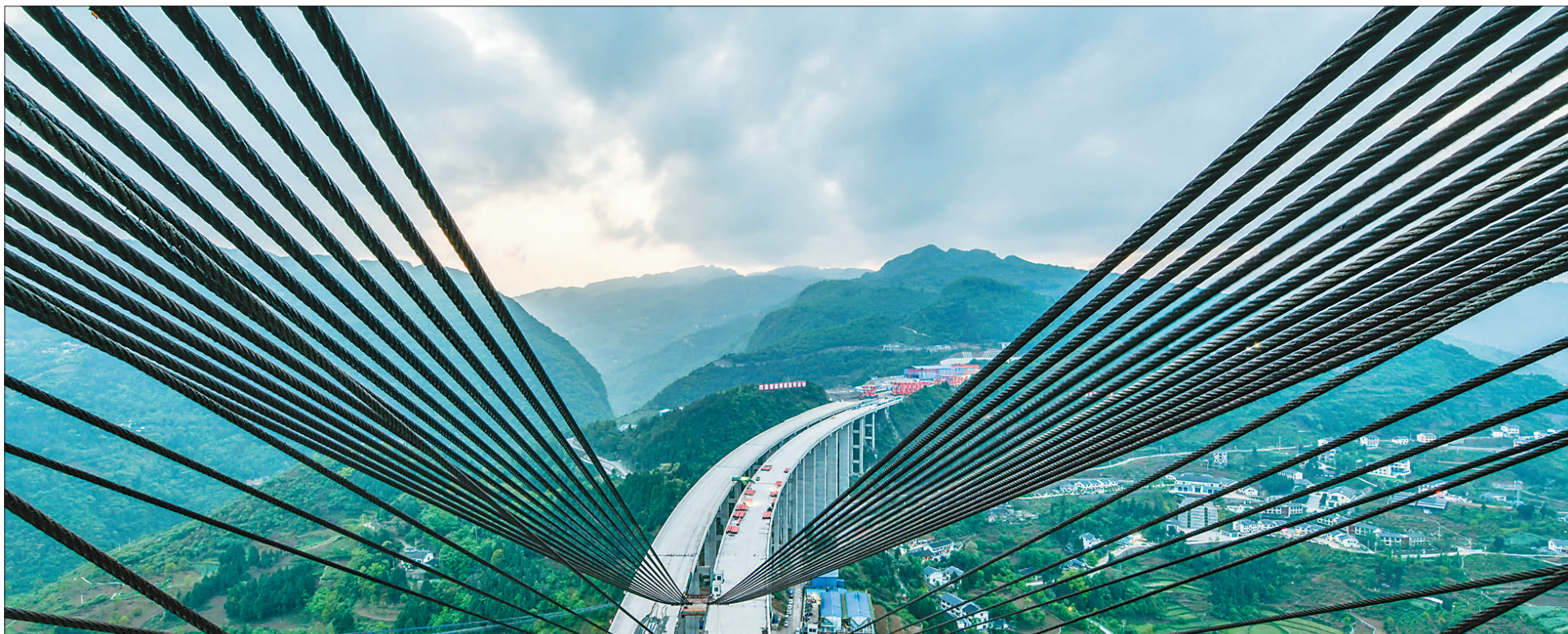
大发渠特大桥位于贵州省遵义市，大桥全长1427米，是仁遵（贵州仁怀—遵义）高速公路的控制性工程之一。图为4月21日拍摄的大发渠特大桥施工现场。 新华社记者 杨文斌摄
