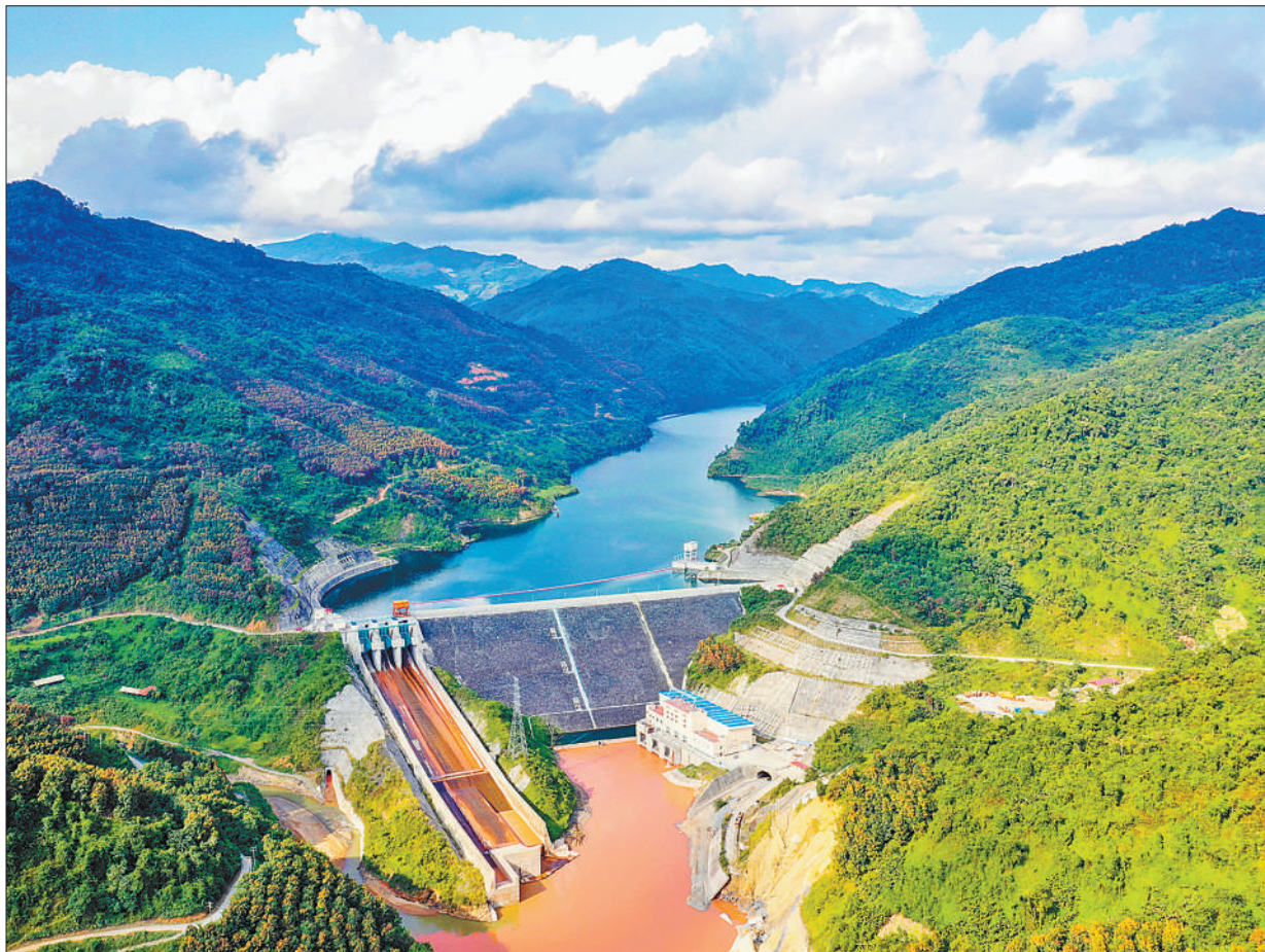
由中国电建投资开发的南欧江梯级水电站项目是改善老挝北部民生的重要项目。图为老挝南欧江六级电站(无人机照片)。
