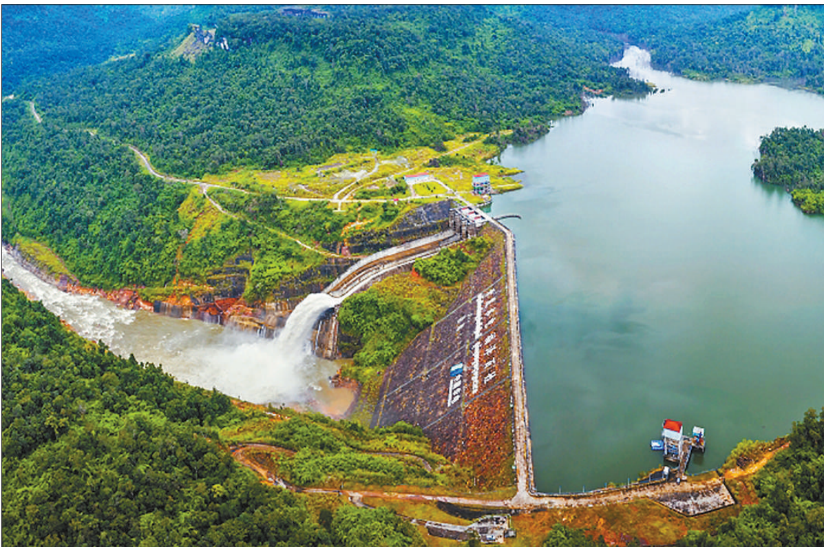
在高质量共建“一带一路”框架下,中企积极参与绿色基础设施建设国际合作。图为中国华电柬埔寨额勒赛水电站项目。
