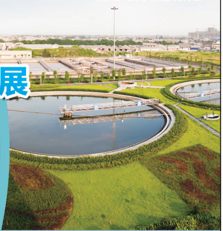
改扩建中的长沙市花桥水质净化厂
