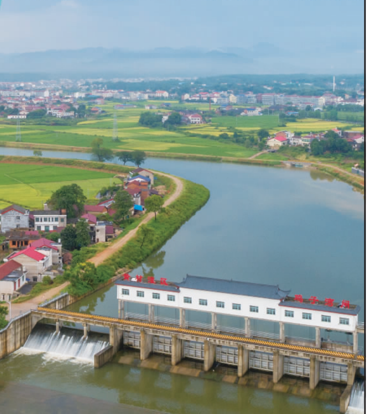
黄材灌区通过续建配套与节水改造改善灌溉面积14.96万亩
