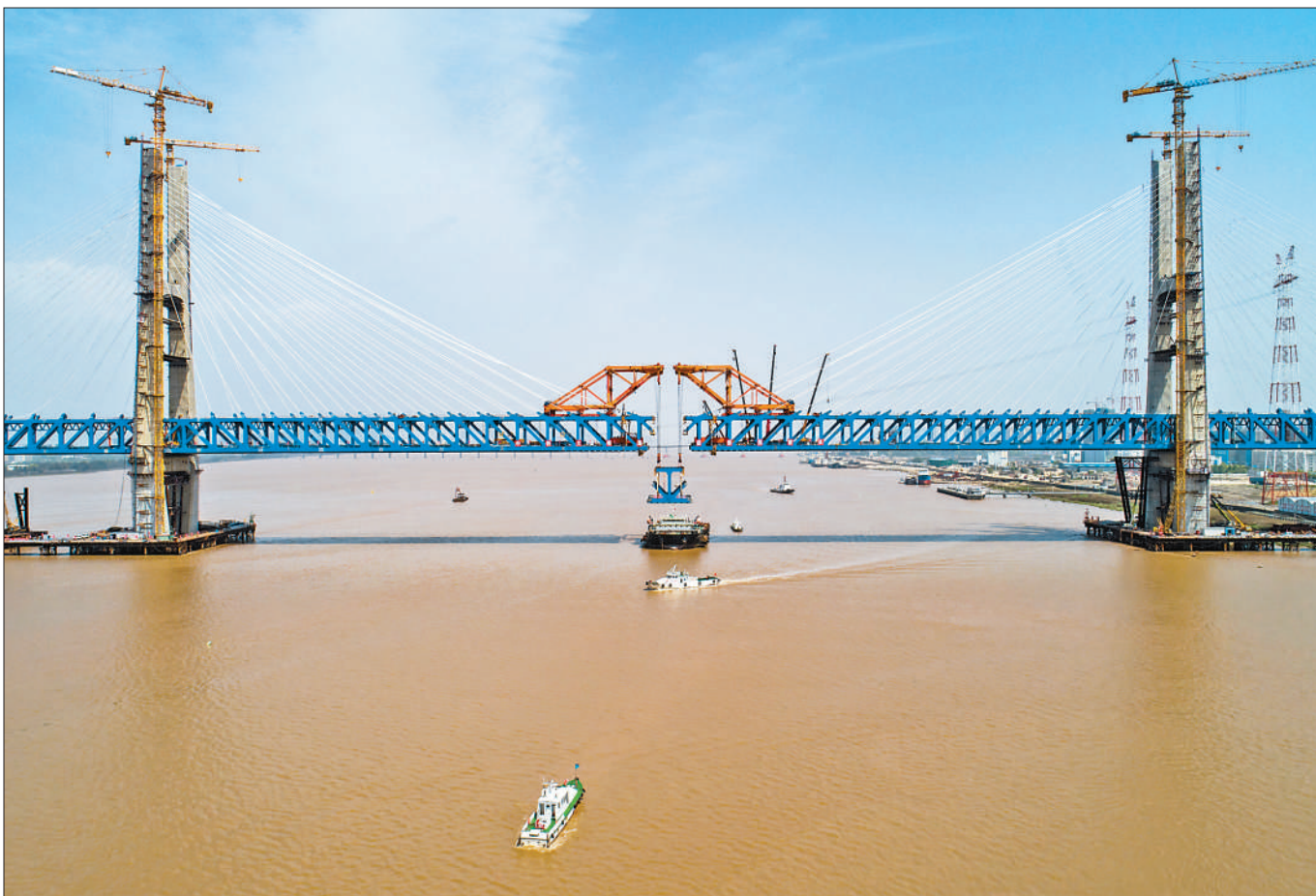
4月17日，在浙江台州的杭绍台铁路建设施工现场，随着最后一段钢梁吊装完成，杭绍台铁路控制性工程椒江特大桥顺利合龙。杭绍台铁路连接浙江杭州、绍兴和台州三地，线路设计时速350公里。图为椒江特大桥合龙现场。
