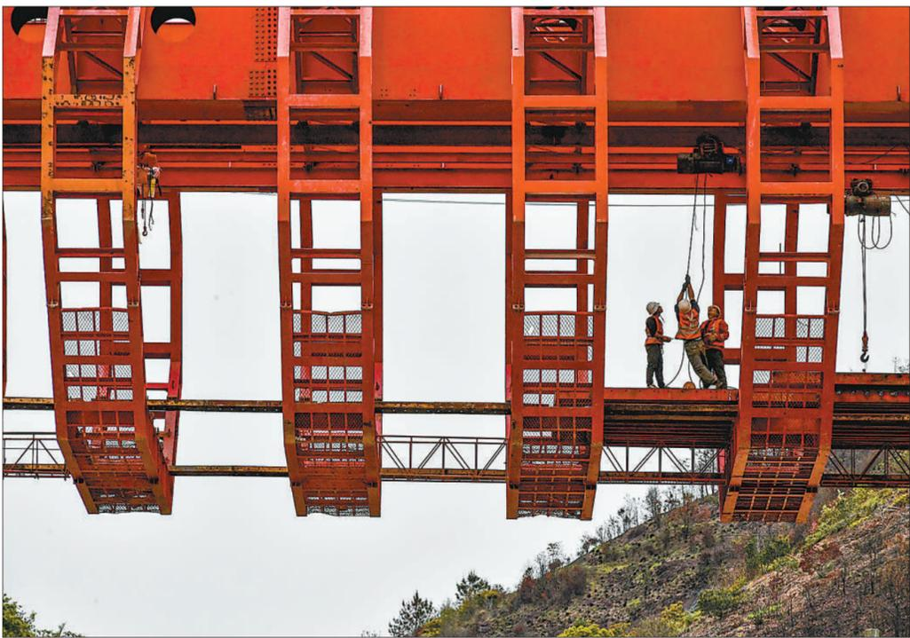
4月10日，浙江省台州市杭温高铁仙居特大桥施工现场，工人正在安装桥梁挂篮模板。
