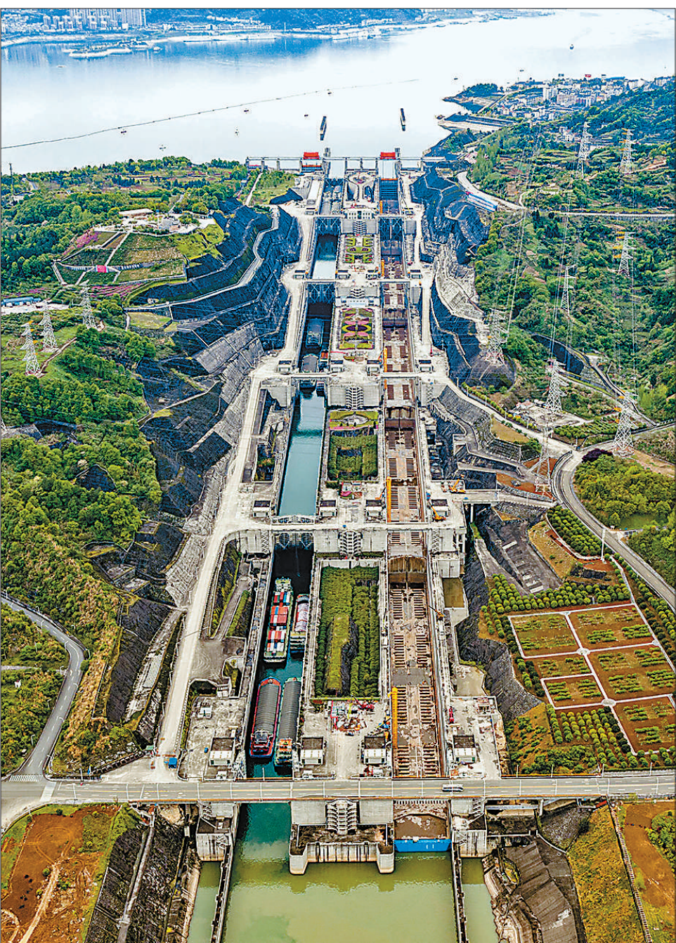
三峡枢纽五级船闸北线计划性停航检修于3月16日开工,计划工期35天,目前施工进度过半。在检修期间,三峡枢纽通航保障有力,各类重点急运物资有序过坝。这是4月5日拍摄的三峡枢纽五级船闸北线检修、南线有序通航的全景图。
