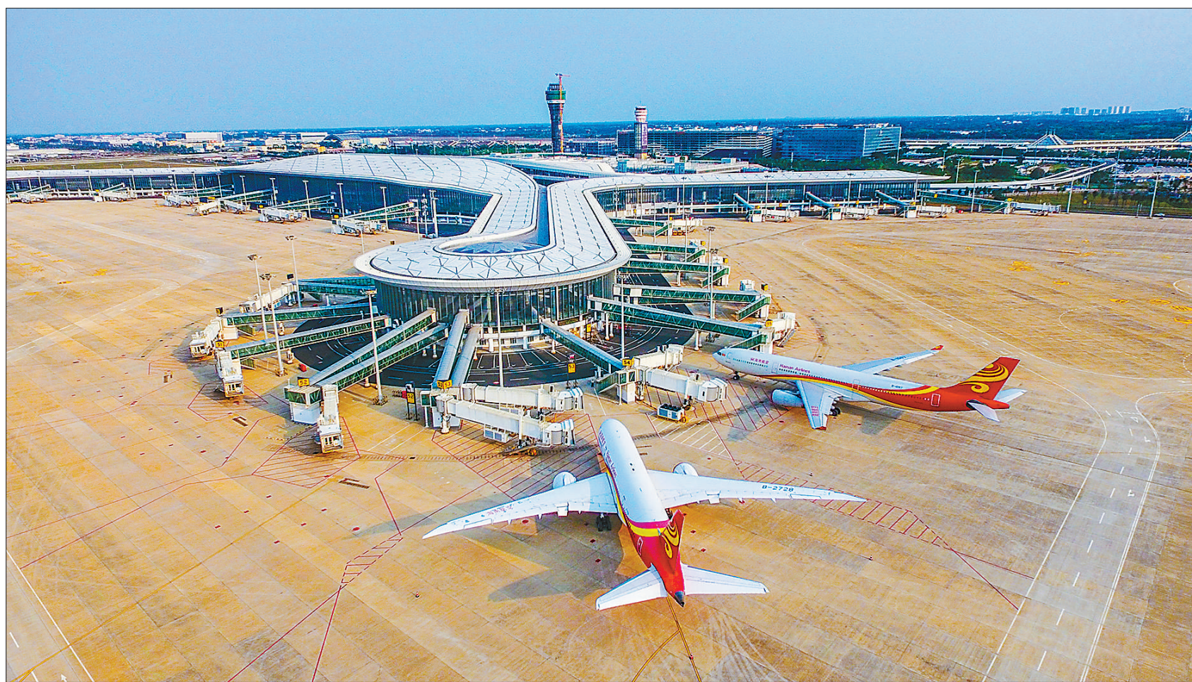
海口美兰国际机场站前综合体东侧区域的新塔台3月31日实现封顶，将有效助推美兰机场二期向全面投入运营使用的目标稳步迈进，为海南自贸港建设积蓄动能。据了解，美兰机场新塔台工程于2020年4月正式开工建设，主要内容包含新建塔台、新建航管楼及配套小区等设施，集成机坪管制、气象观测等多功能区域。
