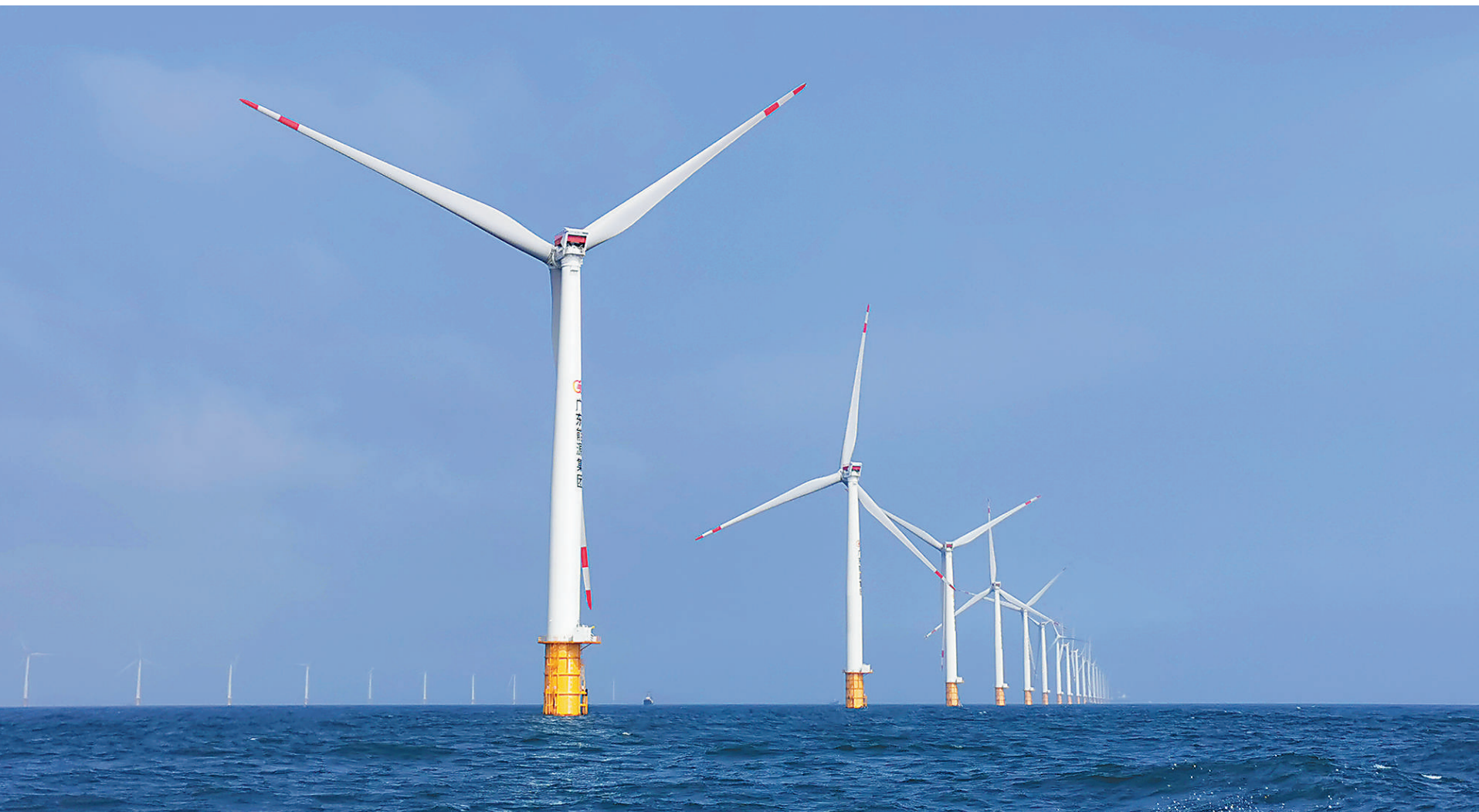
本报珠海4月2日电 (记者李刚)4月2日,总投资约53亿元的广东珠海金湾海上风电场项目全容量并网发电,这是粤港澳大湾区建成投产的首个大容量海上风电场项目。金湾海上风电场总装机容量300兆瓦。项目建成后,每年可提供清洁电能近8亿千瓦时,与同等规模燃煤电厂相比,每年可节省标煤消耗约23万吨,减少二氧化碳排放约46万吨。图为金湾海上风电场。 杨晓菁摄(人民视觉)
