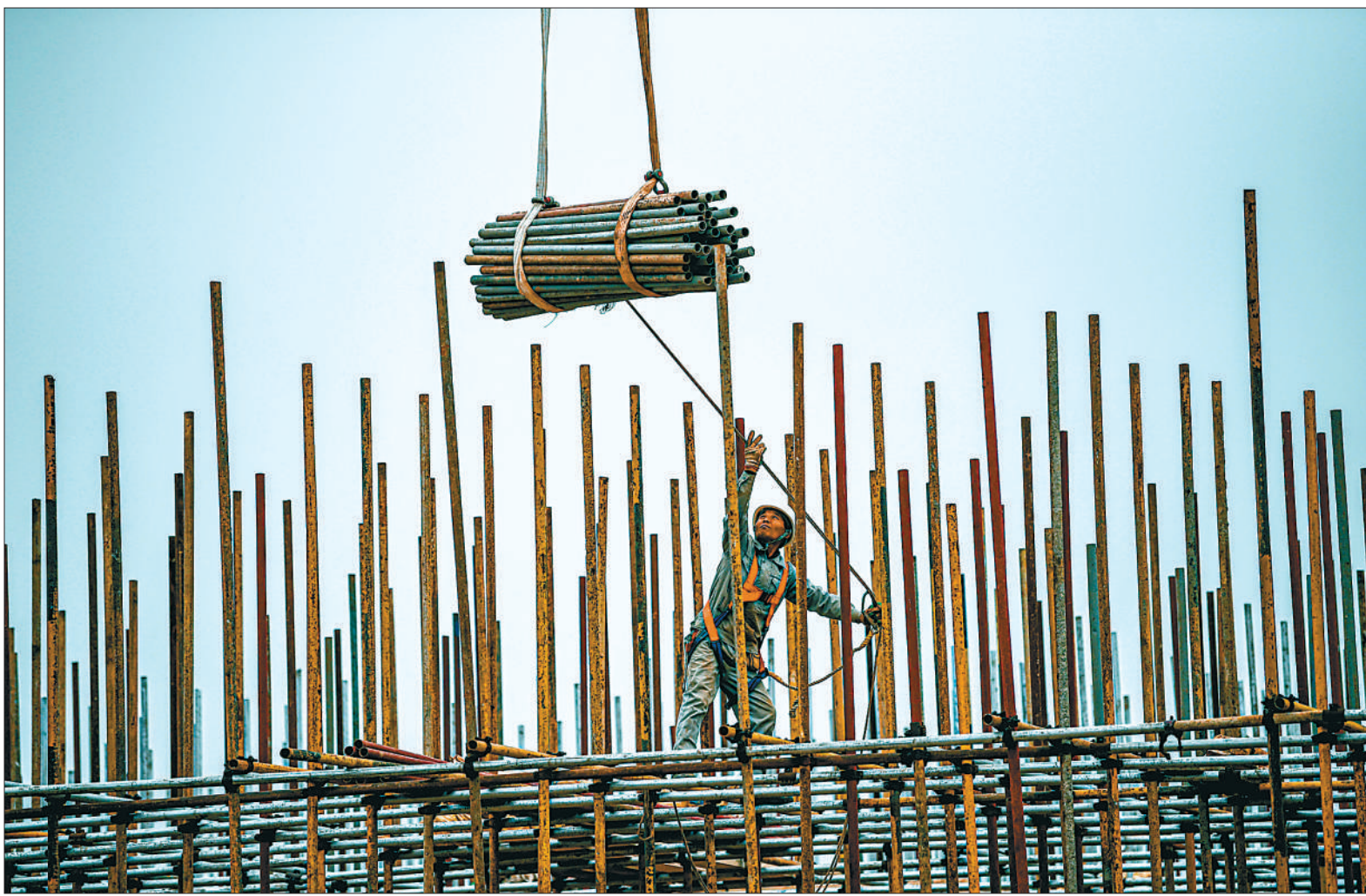
3月23日，海南洋浦经济开发区，工人在工地施工。
