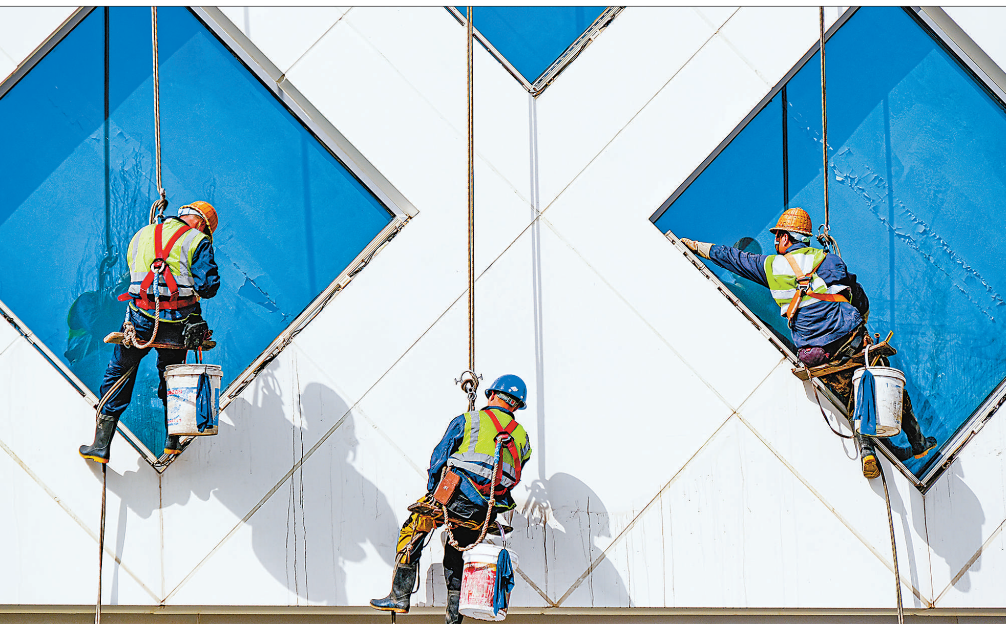
在许多大城市中,高空清洁工人们靠一根保险绳“行走”在高楼大厦外,为高层建筑进行清洁工作,用汗水美化城市高空的每一个角落。图为3月22日,北京顺义区一栋高楼上,几名工人正悬挂于大楼外墙清洗玻璃。
