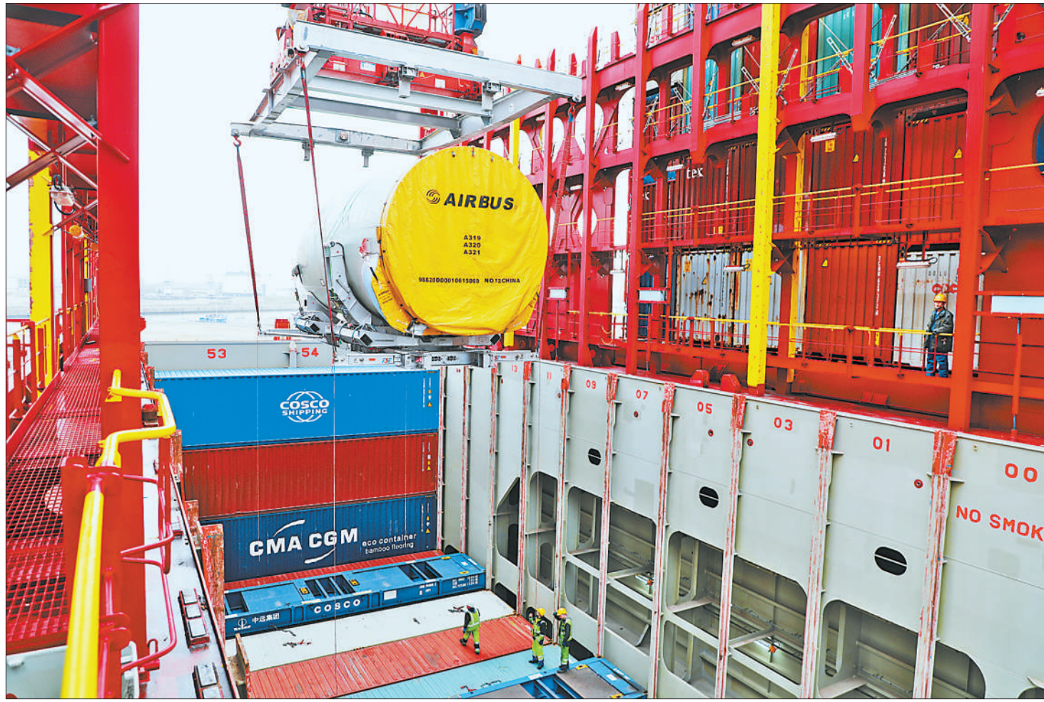
在德国汉堡港内,工人们将空客公司汉堡工厂生产的A320飞机大部件吊装到远洋货运轮,并准备运往中国天津。 本报记者 李强摄
