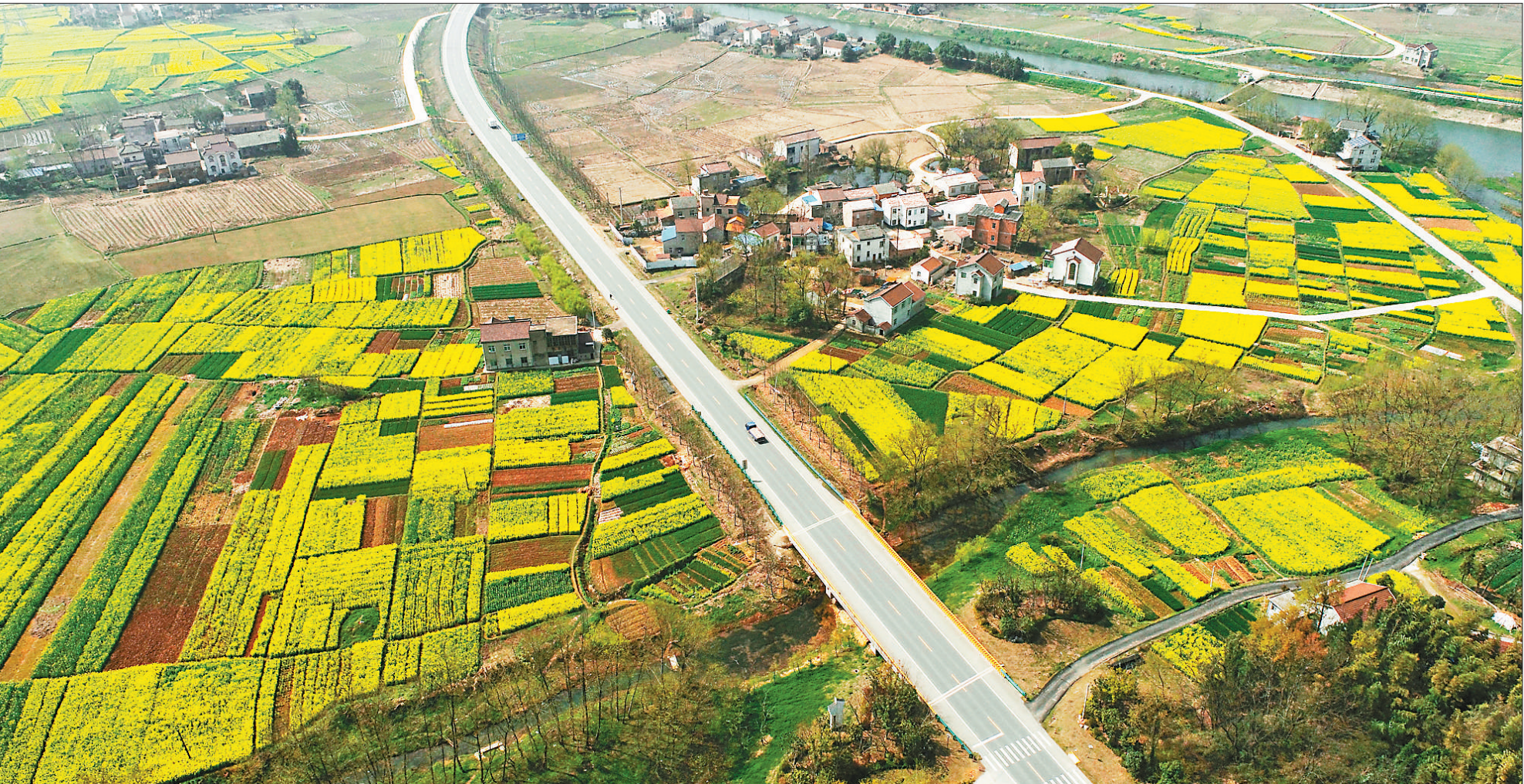
近年来,安徽省合肥市庐江县通过构筑“村村通公路、村村通公交”的城乡交通网,打通农村公路微循环,为拓展巩固脱贫攻坚成果和助力乡村振兴提供了保障。图为3月14日,车辆在庐江县龙桥镇农村公路上行驶。
