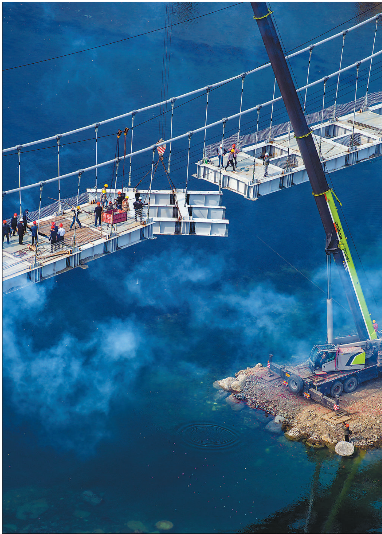
3月14日，湖北省竹山县城关镇堵河五福桥最后一块桁架梁吊装合龙，工程转入桥面施工阶段。近年来，湖北省竹山县大力实施便民桥工程，先后在堵河上建起了19座桥梁，实实在在解决了老百姓过河难题，被称为人民群众与党和政府的“连心桥”。 章磊摄(影像中国)
