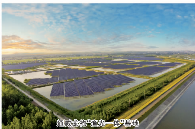
通威龙袍“渔光一体”基地
